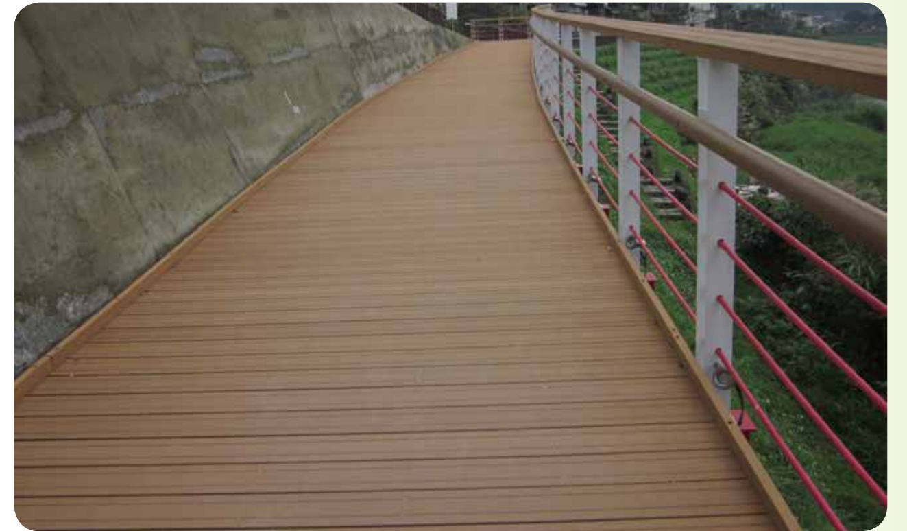
七堵七賢橋旁欄杆與棧道
