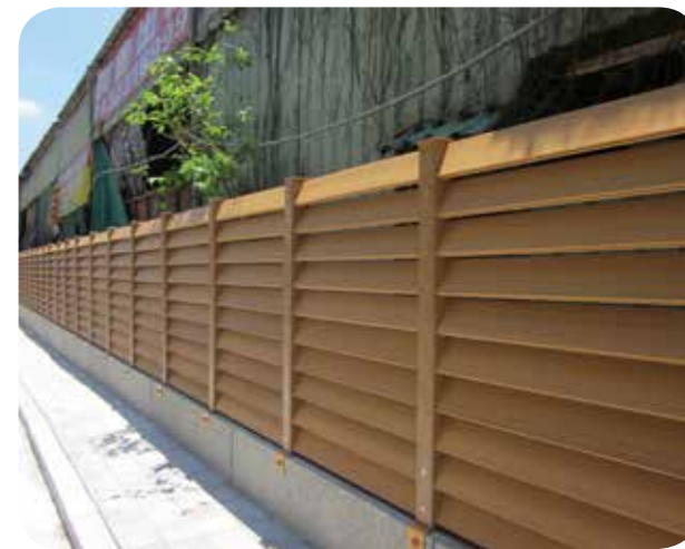
林口病理大樓停車場格柵
