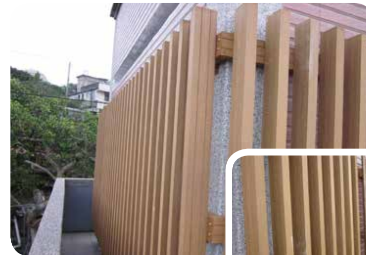
富基漁港安檢所屋頂格柵
