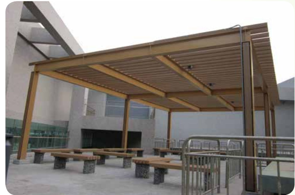
長庚質子中心屋頂綠化工程 型鋼花架
