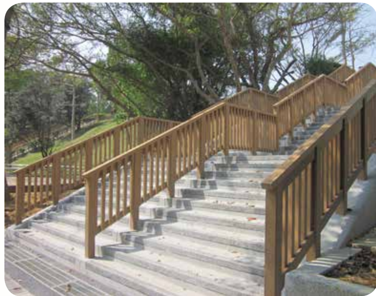
台北永春崗公園樓梯欄杆
