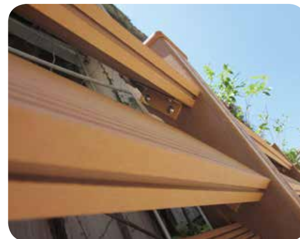
林口病理大樓停車場格柵
